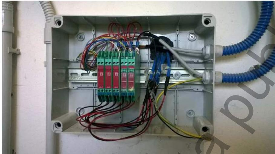
**Fig. 16.5-C – Esempio di cablaggio non corretto**
