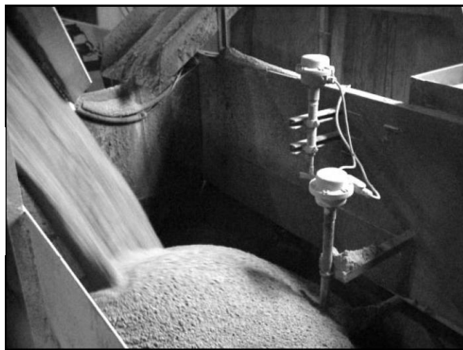
Un impianto di cementificio ha installato due unita' Modello KA nella figura del silo.
